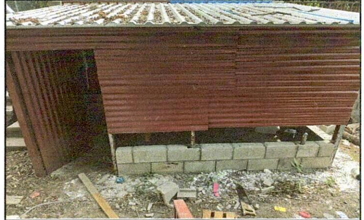
Foto 2: Mejoramiento de cocina, instalación eléctrica, banqueta, block, entre otros.
