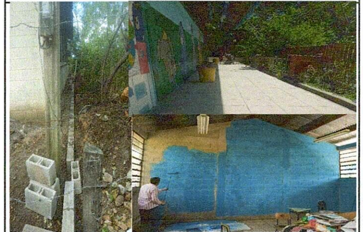
Foto 4: Pintura de los módulos, cambio de piso en el corredor y circulación perimetral con malla metálica.
