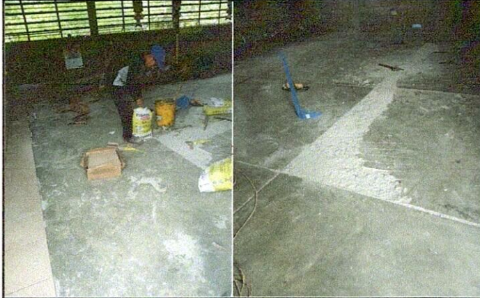
Foto 1: Instalación de piso de granito a los módulos.
