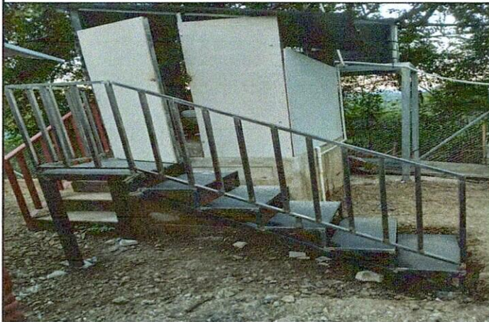
Foto 3: Mejoramiento de baños en el cambio de puertas, separar los baños con tabla yeso, instalación de gradas y banquetas.
